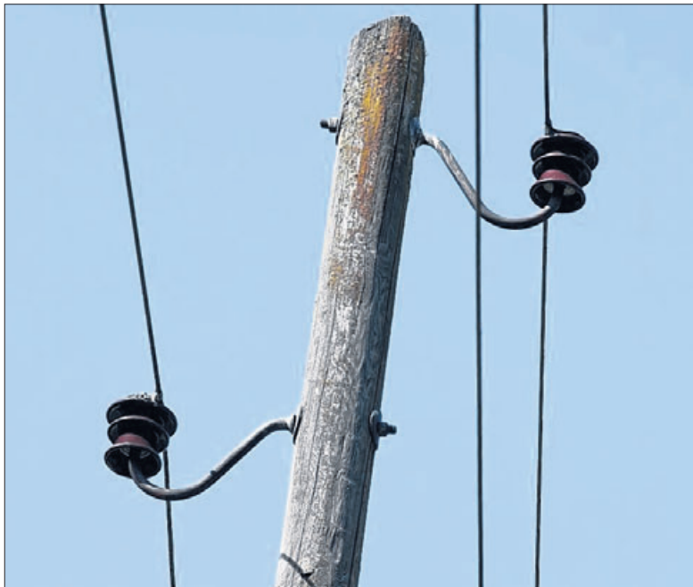
Holzmasten: Jetzt werden alle überprüft.
