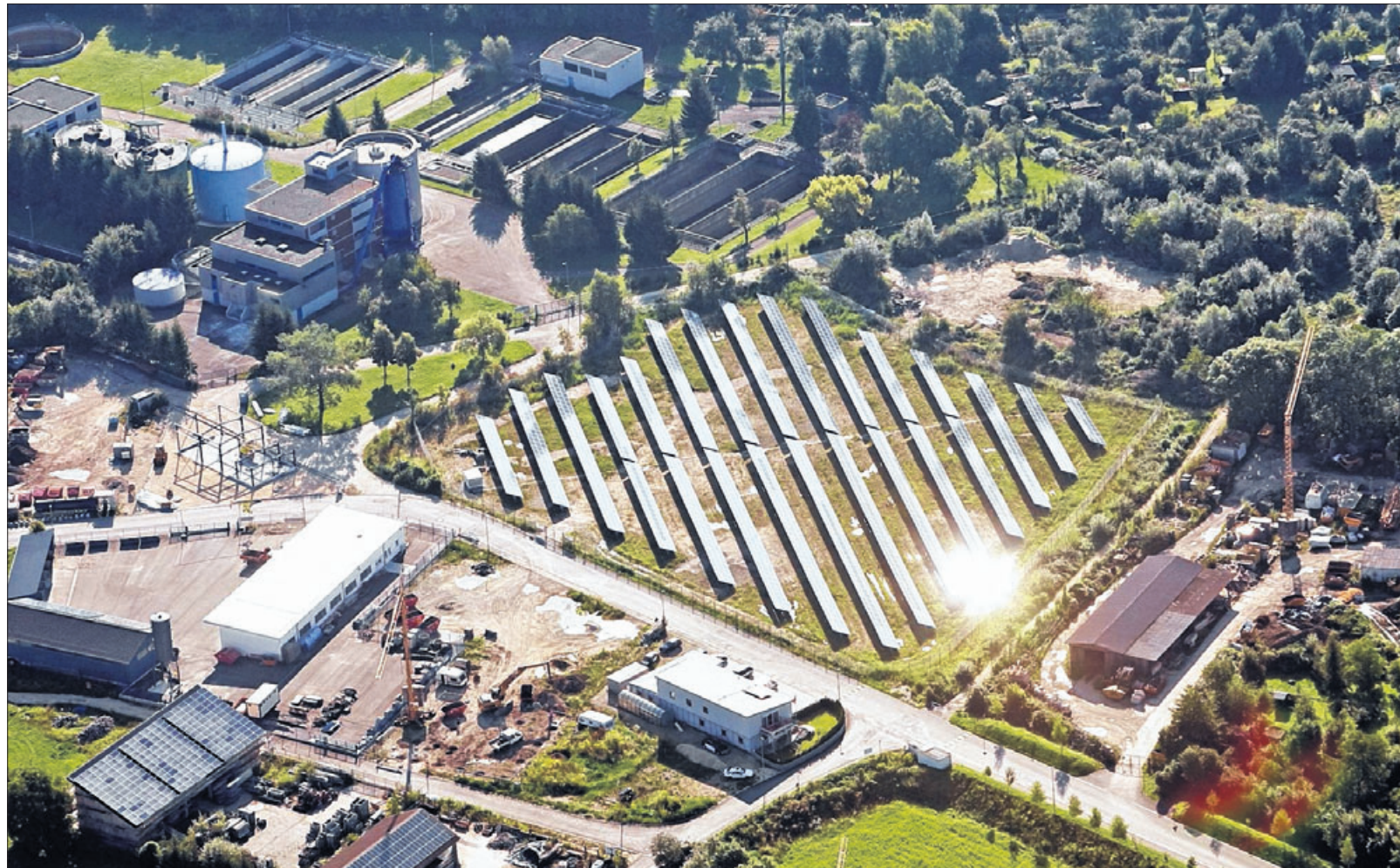
Fotovoltaik: 15 unterschiedlich lange und nach Süden ausgerichtete Modulreihen. Zur Orientierung: Die Zufahrt von der B 10 erfolgt von rechts unten her. Links dieser Straße folgen ein Elektrounternehmen und, ganz links im Bild, der Kuchener Gemeindebauhof. Links oben Teile der Geislinger Kläranlage. Foto: Markus Sontheimer
