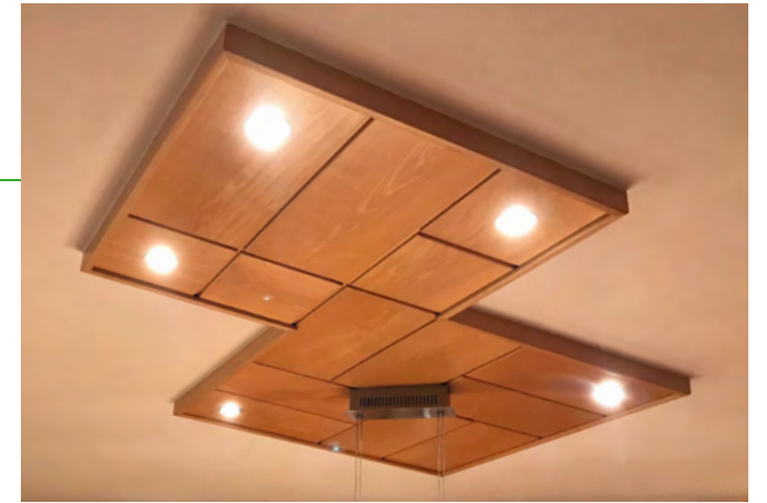
Der Ist-Zustand: energieintensive Halogenstrahler in Wohn- und Esszimmer
