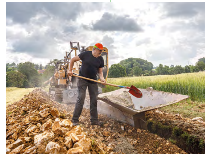
Fräsarbeiten am Kabelschacht
